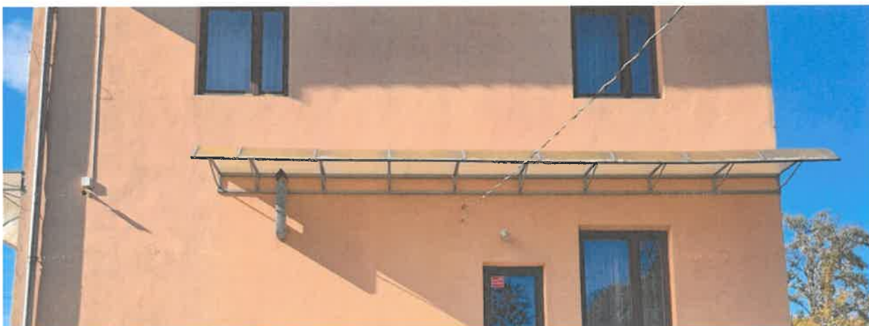
Zadaszenie schodów elewacja południowa DEMONTAŻ I PONOWNY MONTAŻ Z MALOWANIEM KONSTRUKCJI I WYMIANĄ POKRYCIA DASZKU
